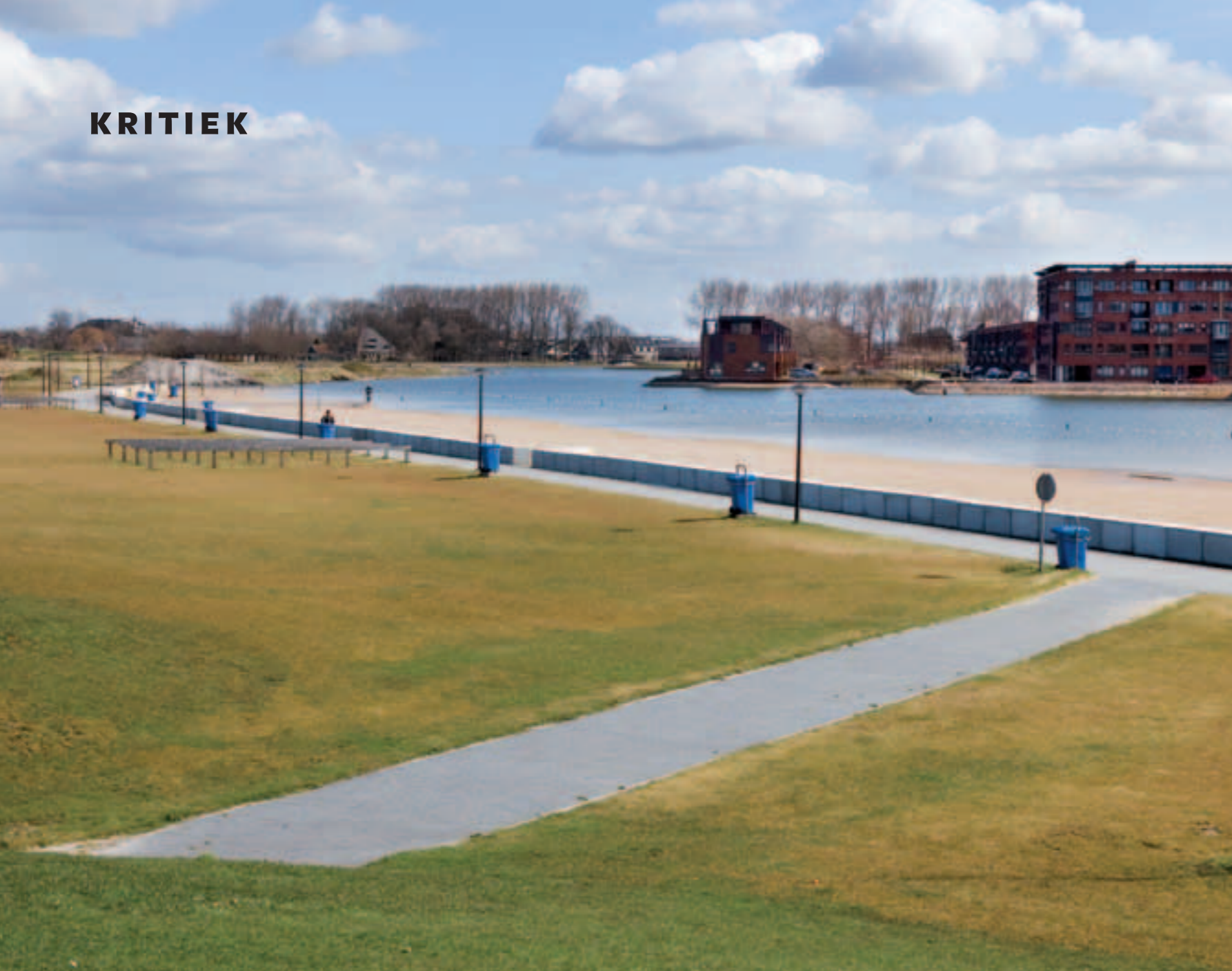
Een batterij afvalcontainers en een betonnen muur die voorkomt dat het strandzand wegwaait.
